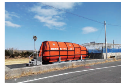
TFCは「東日本大震災で味わった悲しみを二度と繰り返したくない」という思いから、2012年に津波シェルターを開発。現在は岩手県にある子会社ティエフシーで建造している
