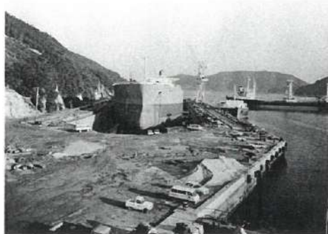
20万トンドック完成直後
